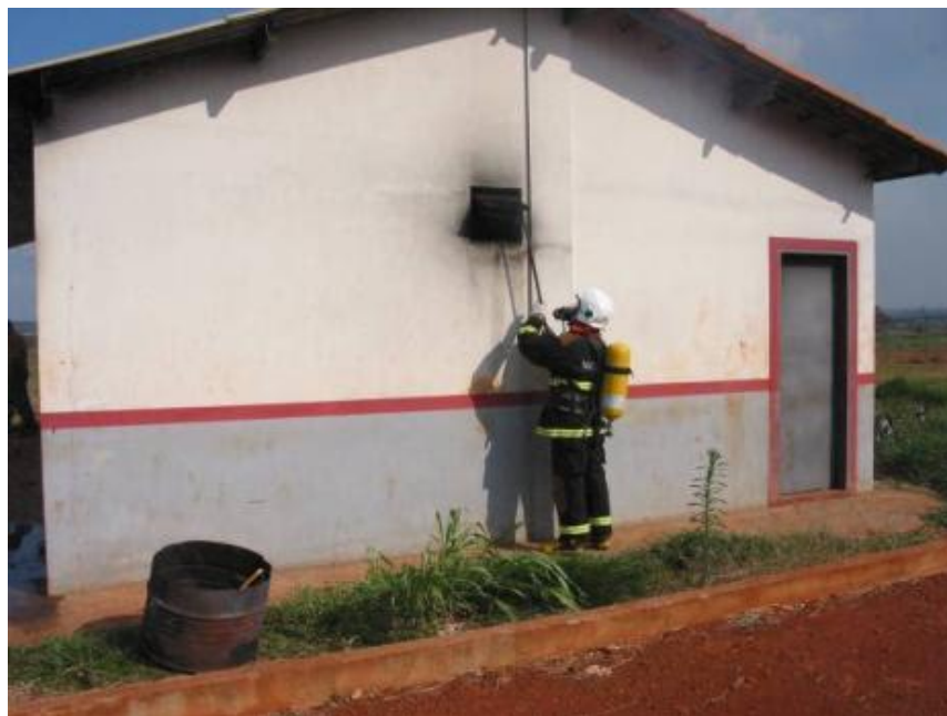
Figura 146 - Abertura realizada pelo lado externo
