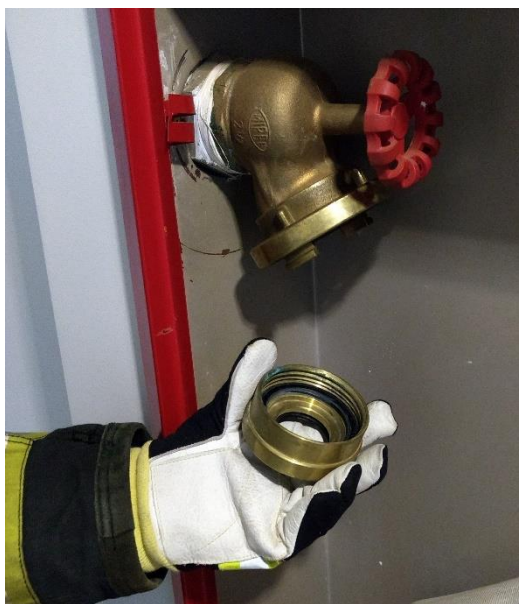
Figura 195 - Adaptador de 1. 1/2" sendo substituído por 2. 1/2"
