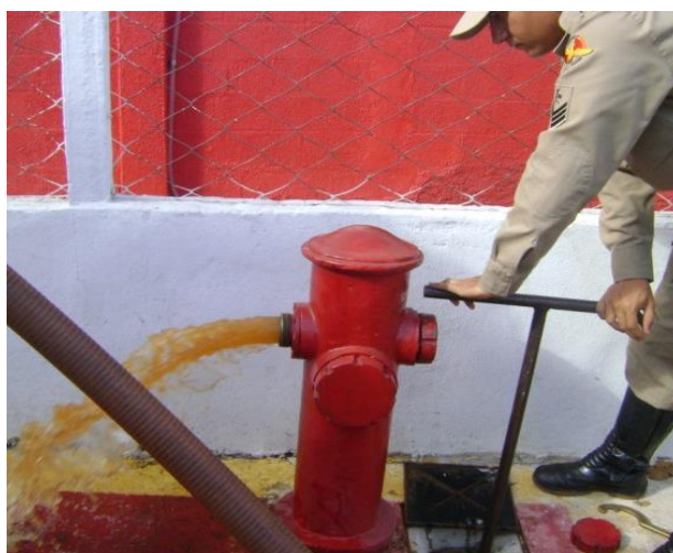
Figura 105 - Conecte e gire a chave tipo T até a abertura total do registro e saída de sujeiras da rede
