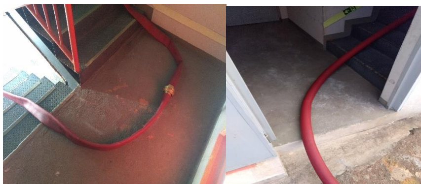
Figura 201 - Ligações estabelecidas na parte externa da caixa de escada
