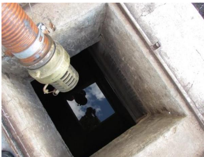
Figura 115 - Posicionar a extremidade do mangote com o ralo no manancial, de modo que fique no mínimo a 60 cm de profundidade. (Se o manancial for relativamente raso, insira uma bacia por baixo do ralo para não captar folhagens ou pedras e prejudicar a bomba).
