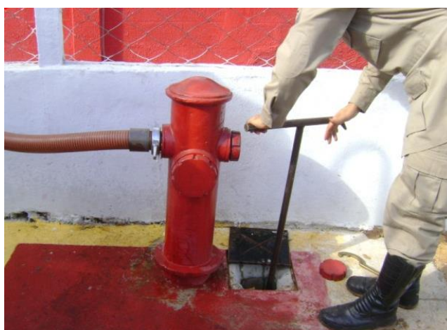
Figura 107 - Gire a chave tipo T novamente até a abertura total do registro
